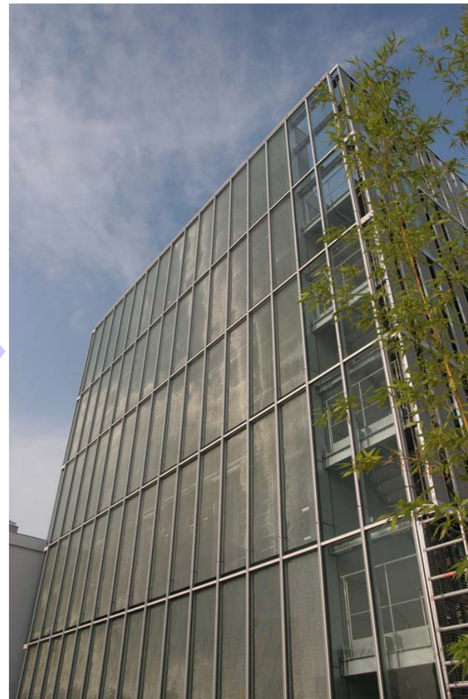
第三データセンター
